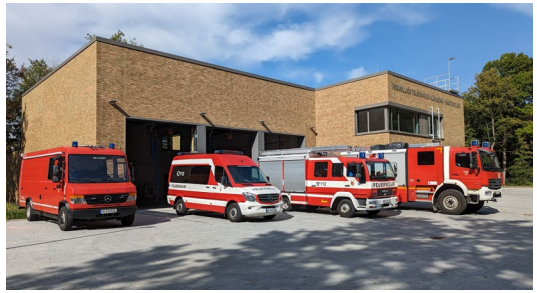
Das neue Gerätehaus im Wacholderweg 77
