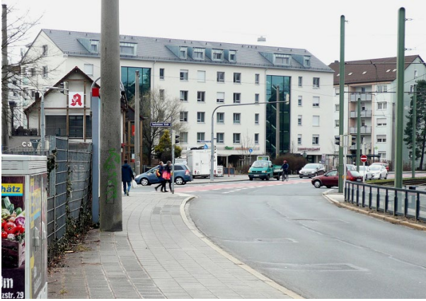
Engstelle des gemeinsamen Fuß- und Radweges
