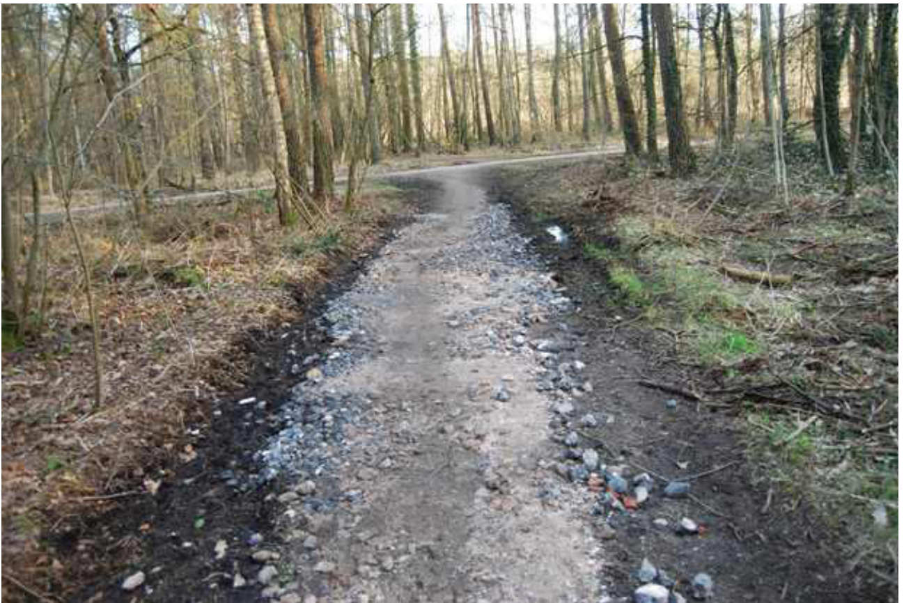
Bauschuttentsorgung durch den Forst
