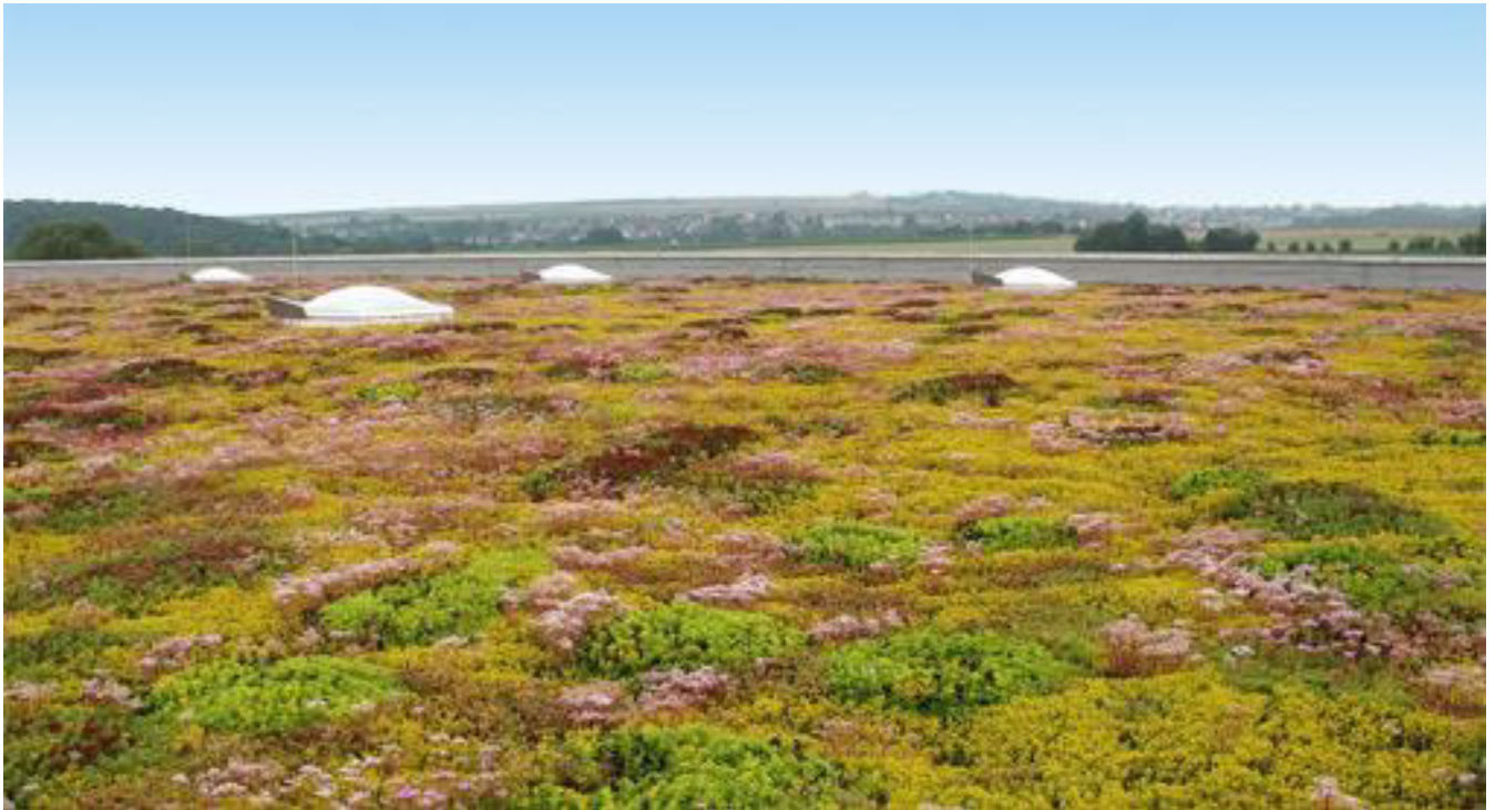
Extensive Dachbegrünung mit einem „Sedumteppich“ auf dem Albertinen Krankenhaus, Hamburg (Bild: Optigruen) Quelle: Optigrün International AG
