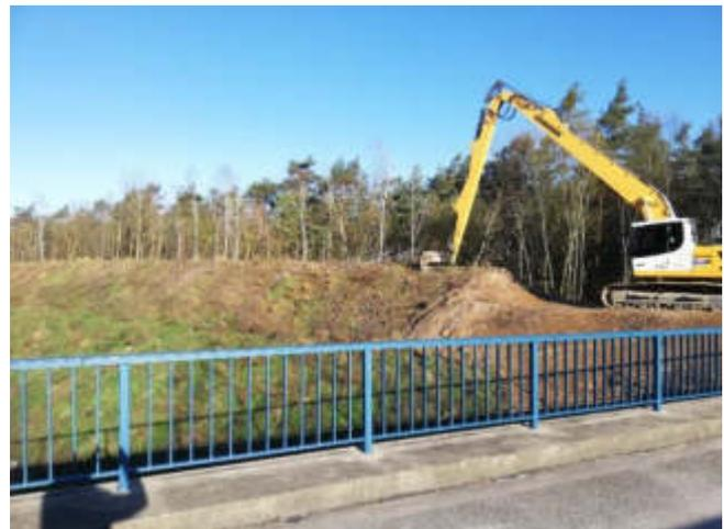
Der Bau der Gabionenwand soll ebenfalls in diesem Jahr angegangen werden. Die Vorbereitungen dazu laufen bereits. Wie im Bild ersichtlich muss die Spitze des Walls für das Fundament teilweise abgetragen werden.
